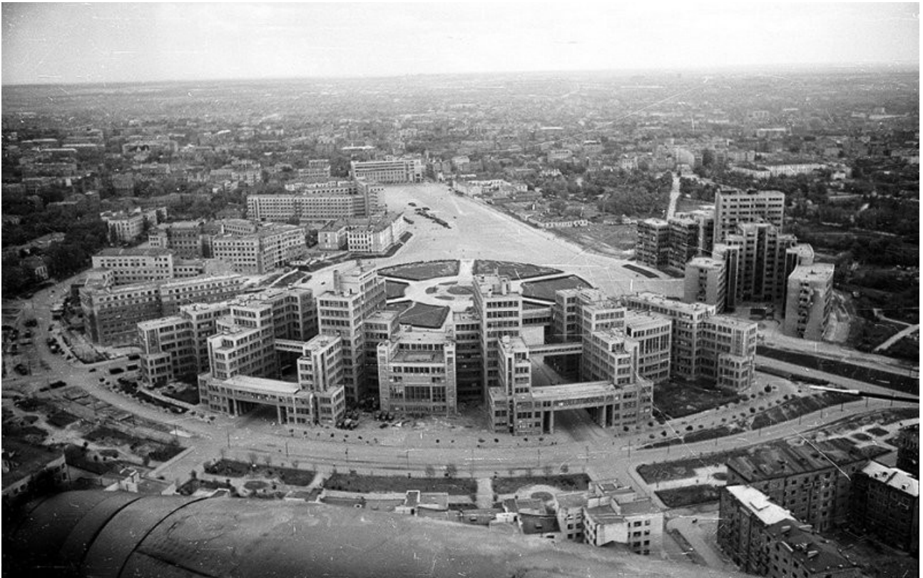
Abb. 4: Deržprom Gebäude am Ploša Dzeržins´kogo (Luftbild, 1942). Quelle: http://www.englishrussia.com
